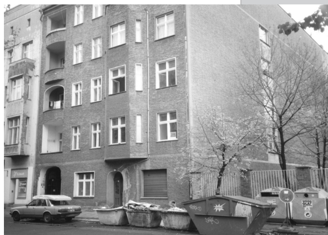
Haus in der Scharnhorststrasse, Seitenansicht. Vom Seitenfenster in der vierten Etage konnte man über die Mauer auf die Westberliner Seite schauen
