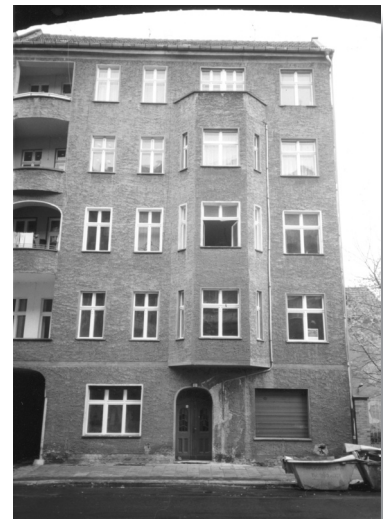
Bereskas Wohnung in der Scharnhorststrasse. Eingang. Die Fenster im vierten Obergeschoss rechts gehörten Gilda und Henryk Bereska
